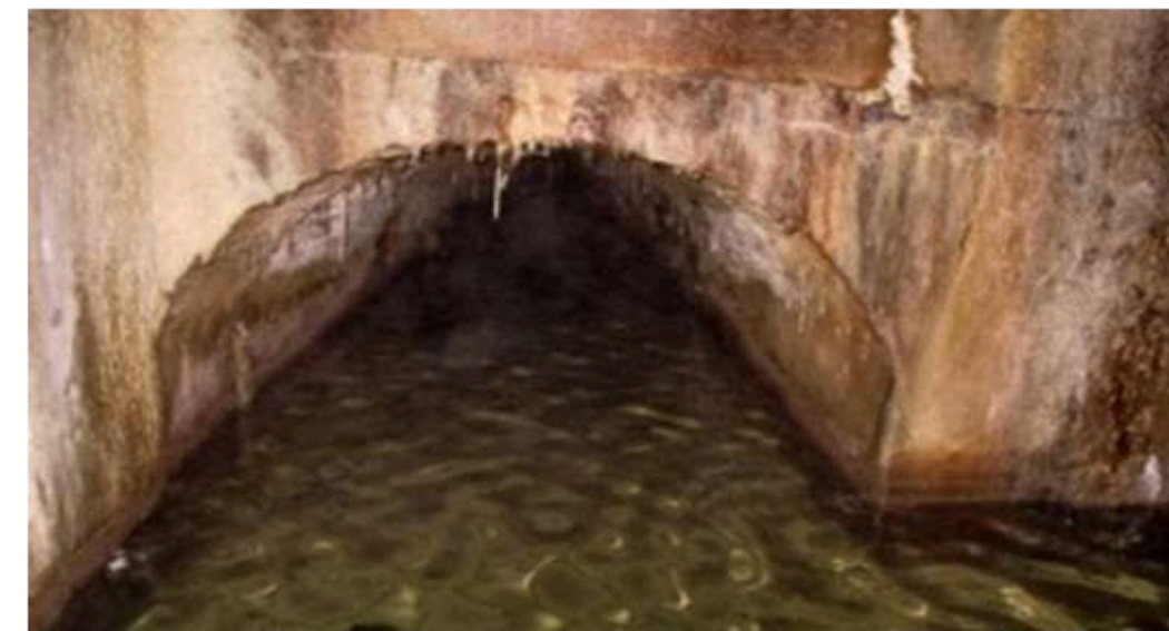
Le tunnel de 300 mètres de long sous les jardins de la ferme
