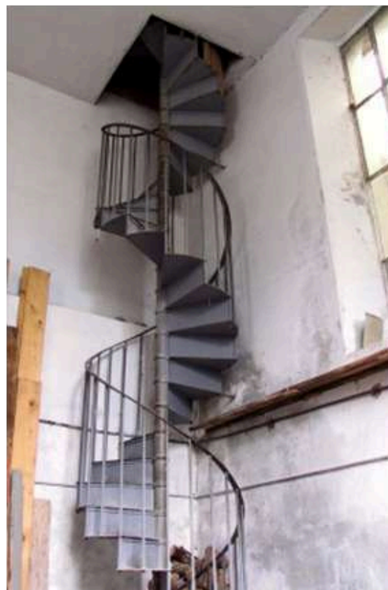
L'escalier à vis de la salle des turbines
