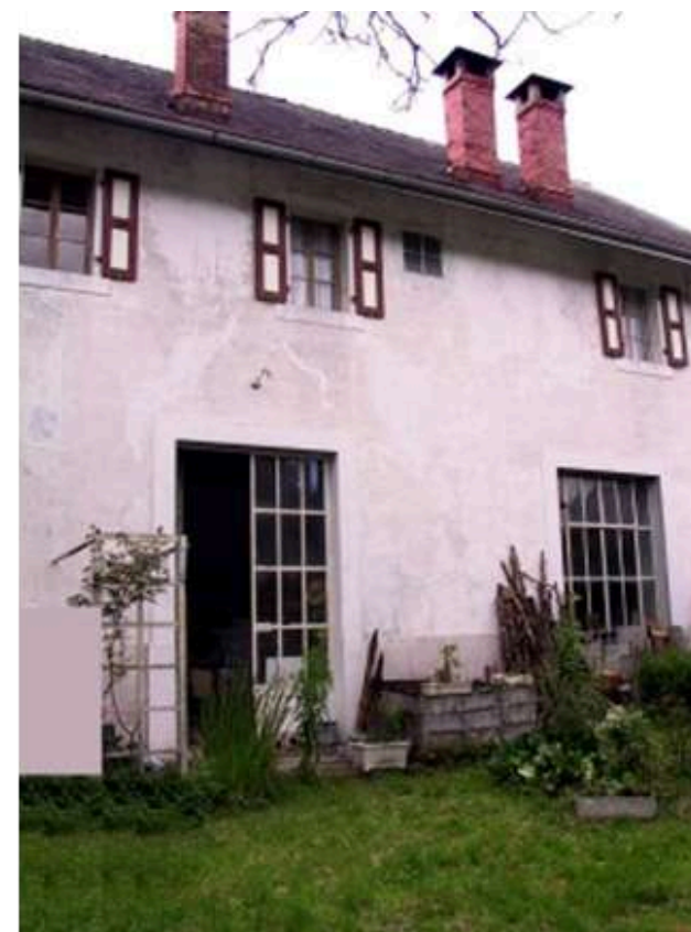
Entrée de la salle des machines de l'usine hydroélectrique
