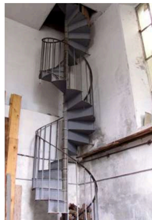
L'escalier à vis de la salle des turbines
