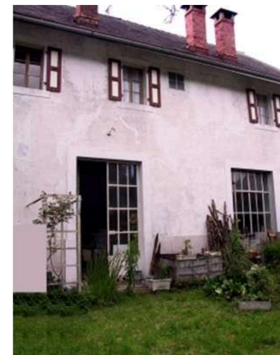
Entrée de la salle des machines de l'usine hydroélectrique
